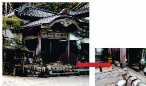
被災後の和倉御便殿本殿と損傷した式台柱
