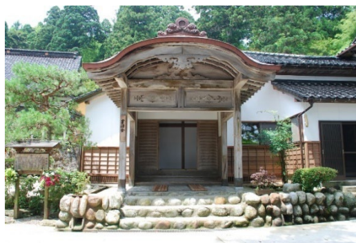
青林寺客殿（和倉御便殿本殿）
